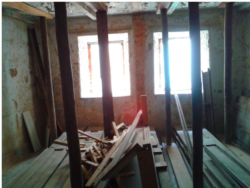
Figura 2: Escoramento da parte interna. Fonte: Liliane Augusta Moreira, 2017.
